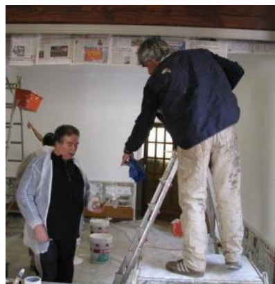
Nicolas Derremience à droite dirigeant le chantier
